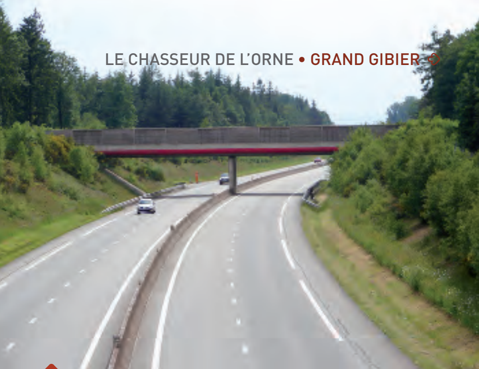
A28 Passage supérieur en forêt de Saint-Évrault
